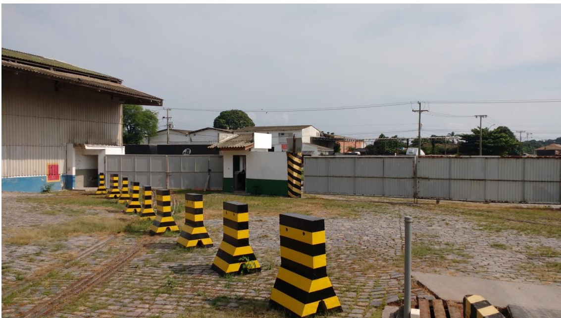
Figura 28 Vista interna ao empreendimento da área de acesso (FONTE: Autor).
